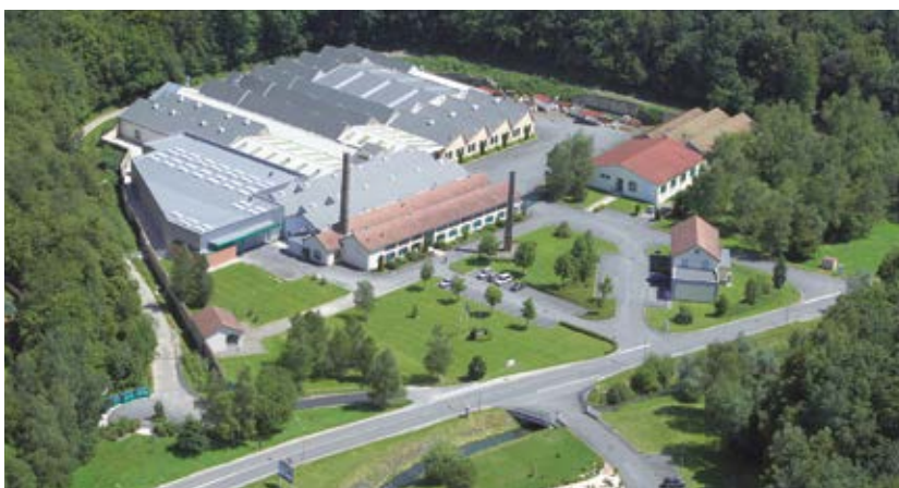
L’usine de Feschès-le-Châtel
